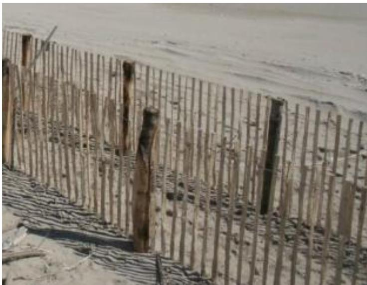
**Figura 2 Esempio di recinzioni di protezione delle dune in materiale naturale (stecche e filo)**
